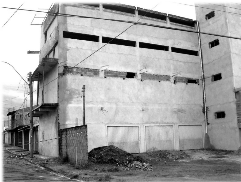
Vista da Edificação – Jardim Bicão – São Carlos
