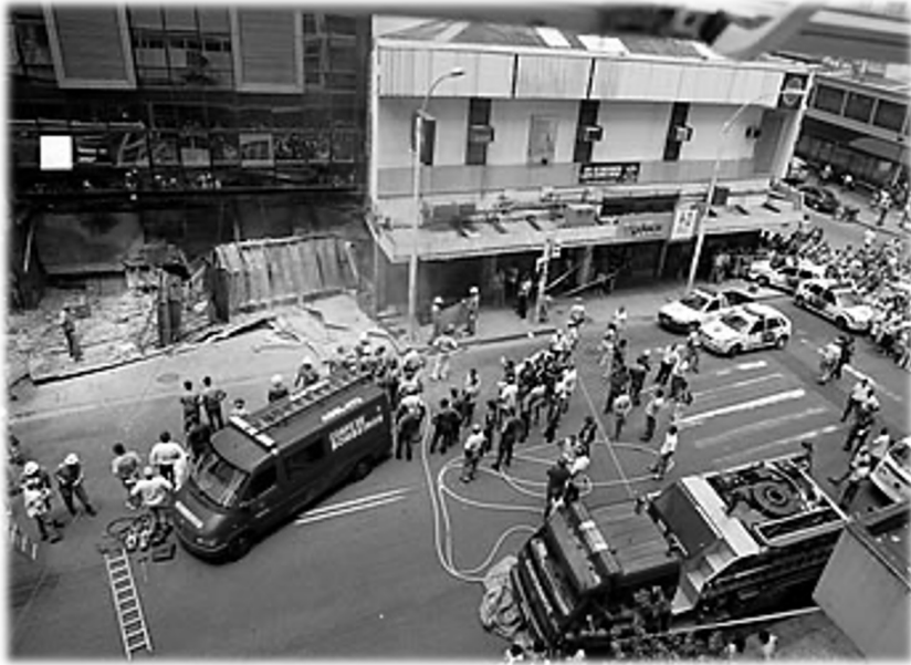
QUEDA DA MARQUISE DO HOTEL CANADÁ - RJ 26 de Fevereiro de 2007
