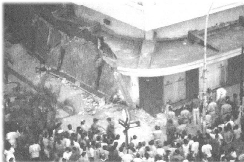
Vista superior da marquise instantes após o desabamento. Detalhe para o esquema com vigas invertidas
