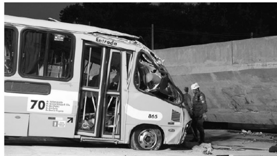
O viaduto, que estava em construção desabou sobre parte de um ônibus, vários caminhões e um veículo que trafegava na Avenida Dom Pedro I, no bairro São João Batista, em Belo Horizonte. (Paulo Fonseca/EFE)
