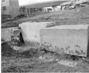
Na imagem, pilar do Batalha dos Guararapes afundado sobre o bloco que se rompeu
