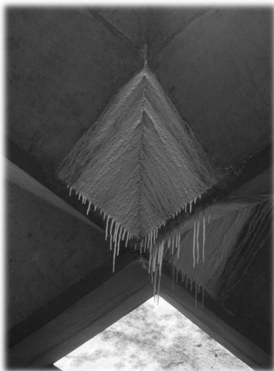
Cobertura do Prédio da FAU-USP
