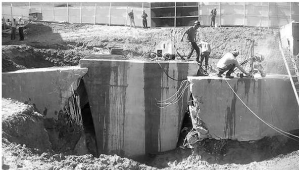
O pilar P3, que afundou pelo meio do bloco devido a dimensões inadequadas, segundo aponta laudo do Instituto de Criminalística
