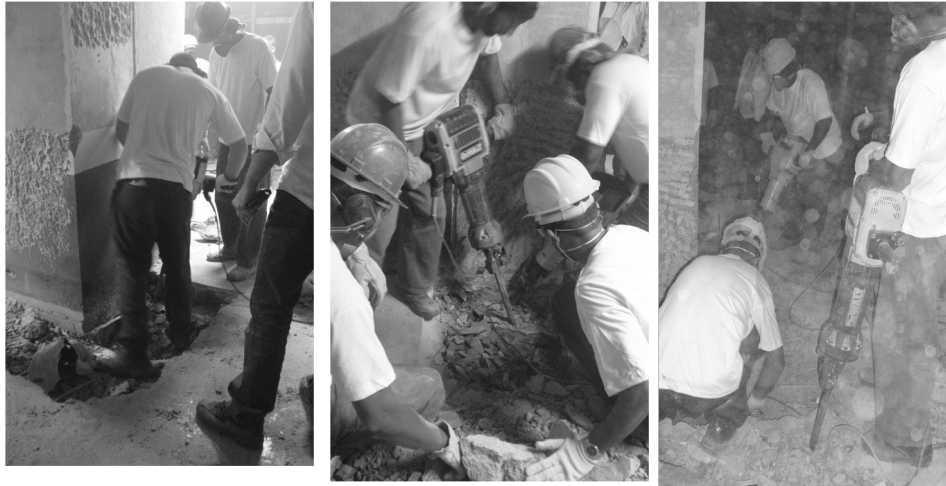
Demolição Piso fase 1
