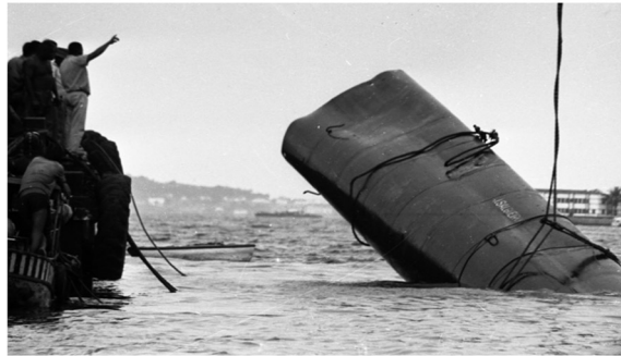
Num teste de carga, foto em 24 de março de 1970, plataforma flutuante não resistiu e levou à morte de oito pessoas, entre elas três engenheiros. Foto: Arquivo/Ag. O Globo.
