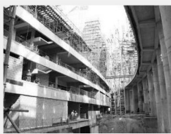
Construção do estádio de Brasília tem quatro mil operários (crédito: Lula Lopes)
