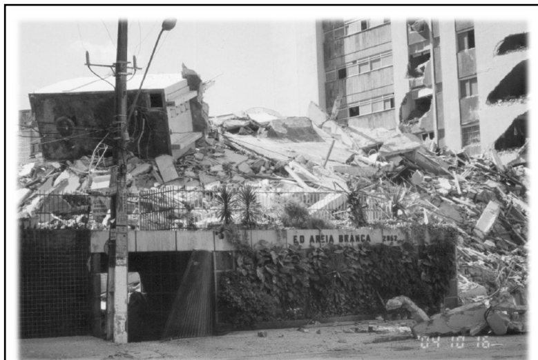
Escombros - manhã seguinte do desabamento
