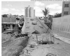
Aberturas são feitas para, durante a obra, criar acesso à parte inferior do tabuleiro
