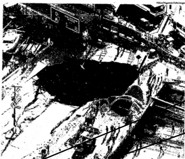
Vista aérea do buraco, às 19h10, formado em cruzamento da avenida Santo Amaro e Marginal Pinheiros.
