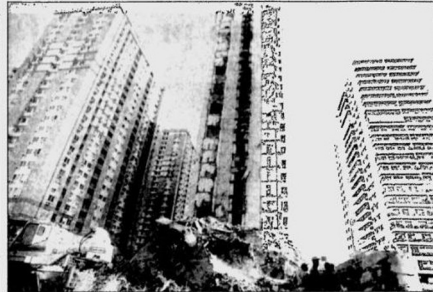
A coluna com 14 apartamentos (igual à do edifício à direita) transformou-se em escombros
