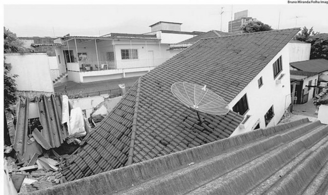
A CASA CAIU Sobrado na rua Amaro Cavalheiro, em Pinheiros (zona oeste de SP), que desabou em túnel da obra da linha 4 do Metrô; outra casa e um estacionamento foram afetados e todos os moradores do quarteirão foram retirados Pág. A20 Folha de São Paulo, 04 de dezembro de 2005
