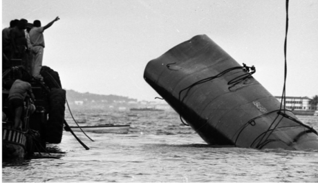
Num teste de carga, feito em 24 de março de 1970, plataforma flutuante não resistiu e levou à morte de oito pessoas, entre elas três engenheiros. Foto: Arquivo/Ag. O Globo.
