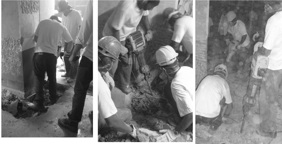
Demolição Piso fase 1
