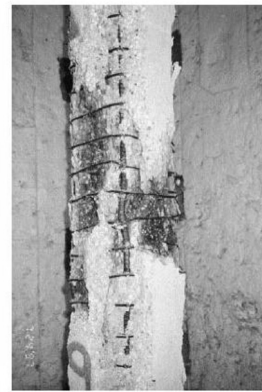
Configuração Modificada de Estribos
