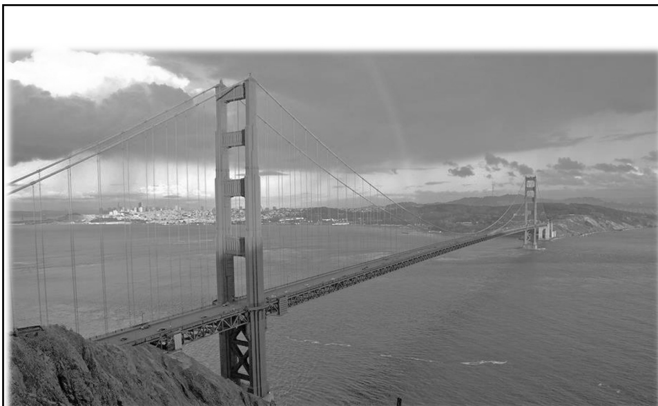
Puente Golden Gate, São Francisco, USA → 1.933 Joseph Strauss puente suspendida con cables de acero galvanizados
