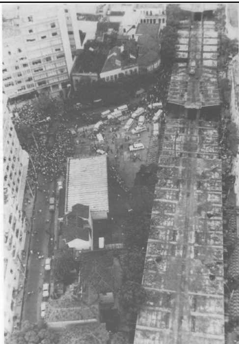
Desabamento do elevado Paulo de Frontin em 1971 — O Globo
