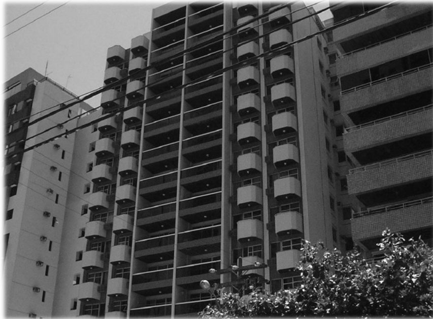
EDIFÍCIO AREIA BRANCA – Pernambuco
