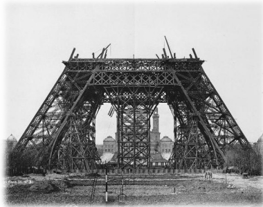
20 de marzo 1888: instalación de plataformas horizontales
