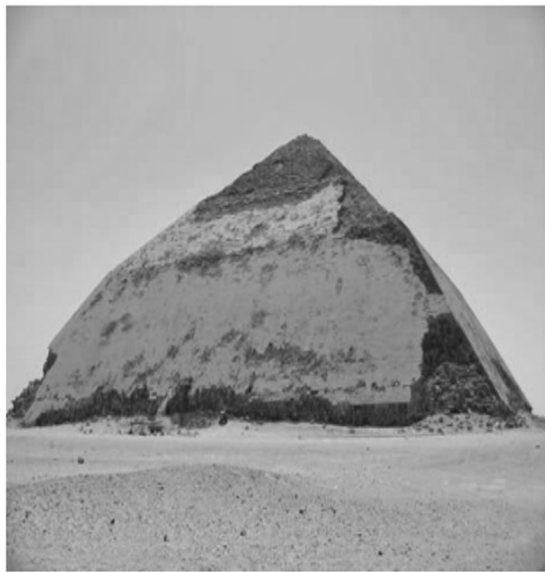
A segunda pirâmide de Sneferu, chamada de pirâmide romboidal. Um erro de cálculo levou a pirâmide ceder ao próprio peso, encurvando suas arestas.
