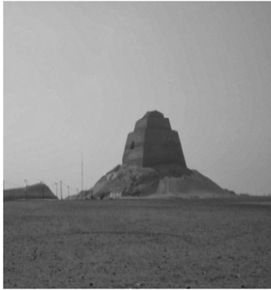
A pirâmide de Meidum, a primeira pirâmide projetada para o faraó Sneferu. Contudo, complicações na construção levaram ao desabamento de parte da estrutura. O revestimento da pirâmide caiu a vários séculos.
