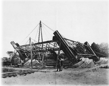
18 de julio 1887: comienzo de montaje del pilar 3
