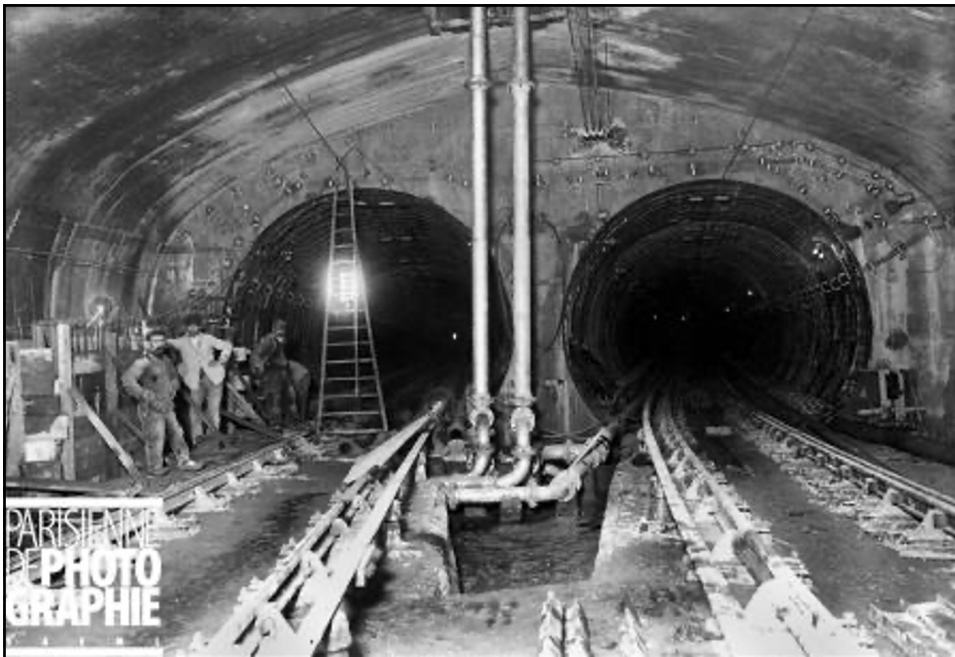
1900 Construction de la voûte nord-sud sous la place de la Concorde
