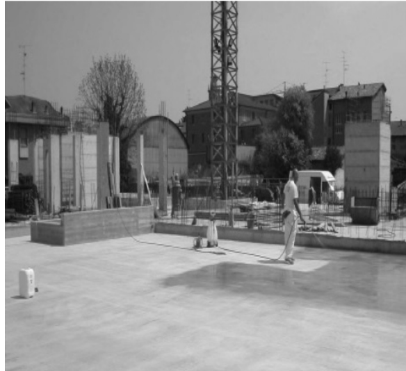
Hidratação de laje de concreto após aplicação do silicato de sódio
