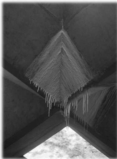
Cobertura do Prédio da FAU-USP
