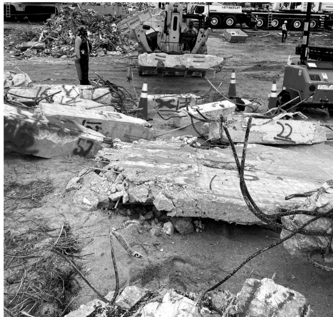
Losas colapsadas
