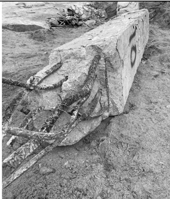
Columnas colapsadas
