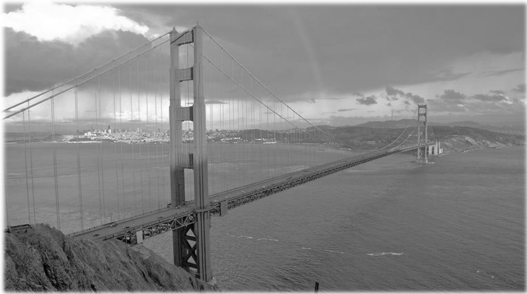
Ponte Golden Gate, São Francisco, USA → 1.933 Joseph Strauss ponte suspensa com cabos de aço galvanizados
