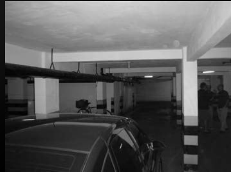
Vista geral do subsolo
