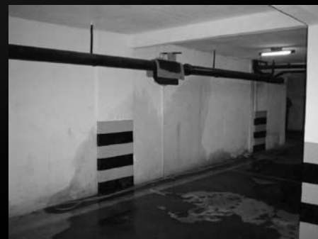
Vista geral do reservatório inferior e alagamento
