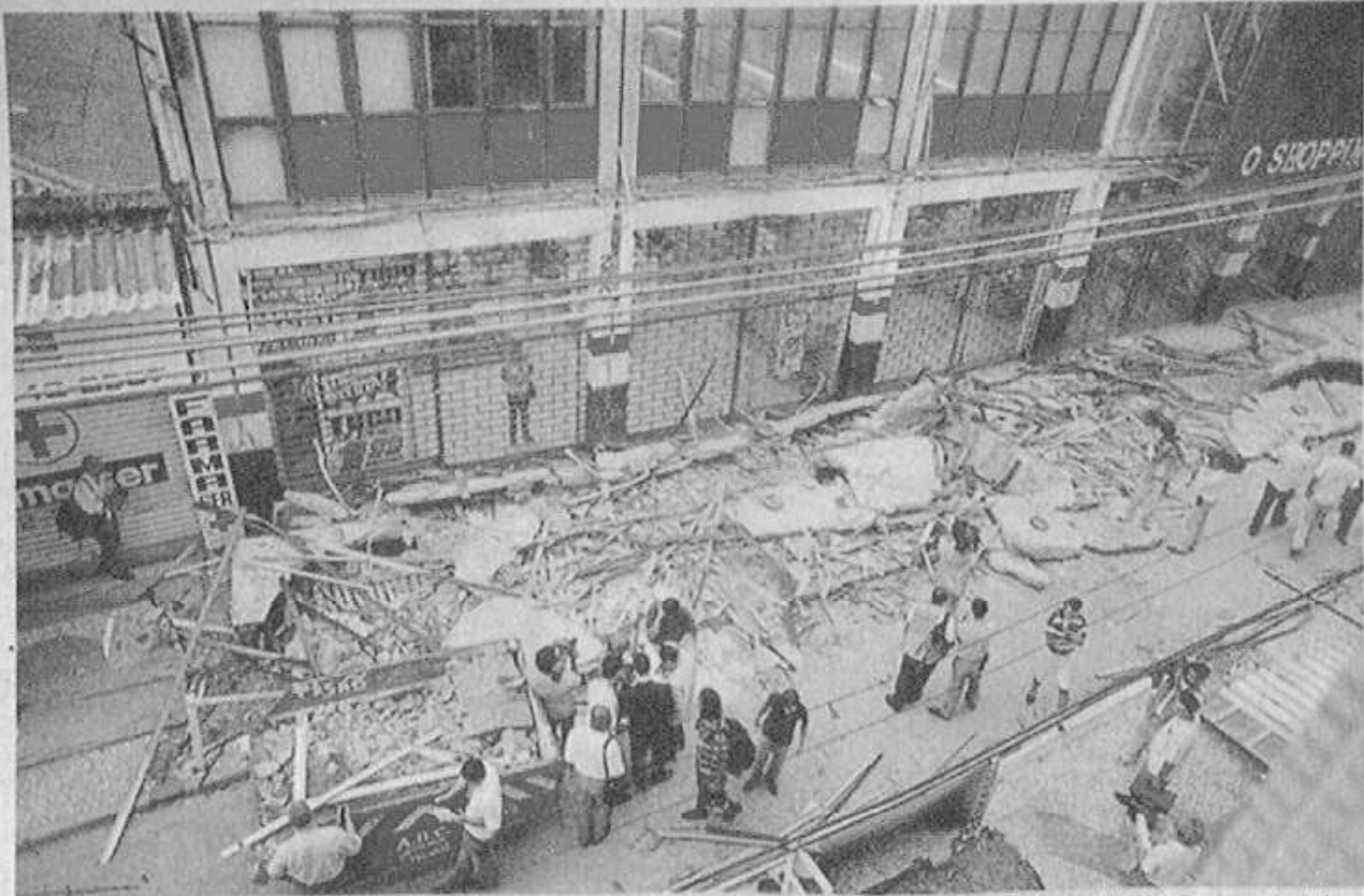
Destroços das duas marquises de 30 metros de comprimento que desabaram da fachada de loja no centro de São Caetano do Sul
