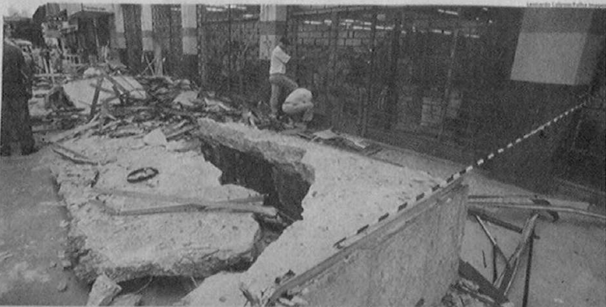
Área interditada em calçada do centro de São Caetano com parte da marquise que desabou de prédio comercial, matando duas pessoas ontem
