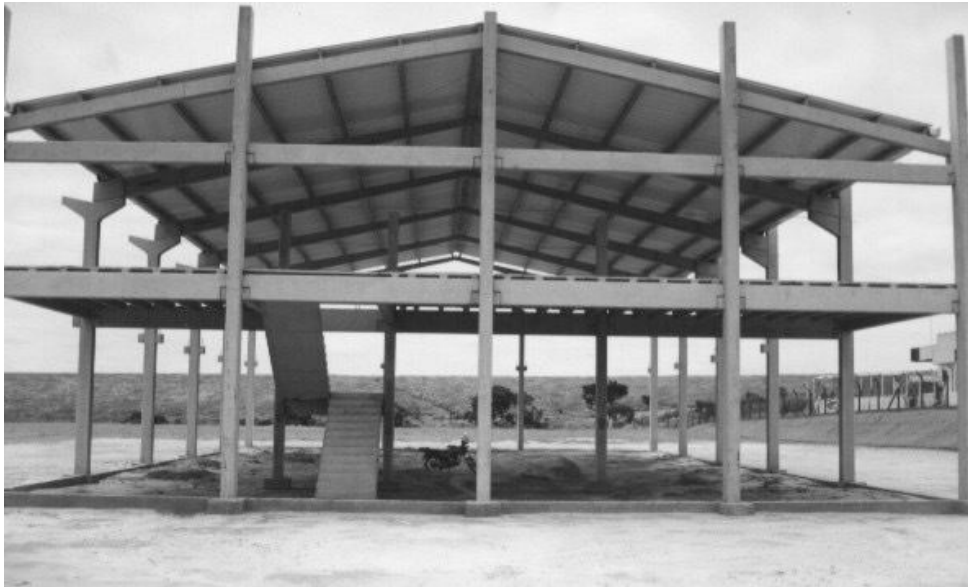
Figura 22 – Exemplo de galpão leve com mezanino
