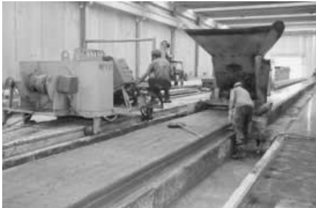
Figura 1: Produção industrial de laje alveolar durante a moldagem do concreto protendido
