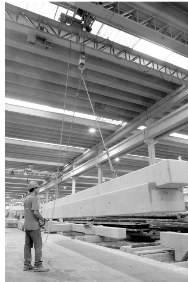
Figura 37 – Movimentação de viga pré-fabricada durante a produção
