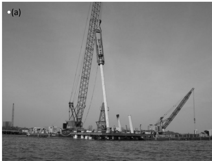
Figura 34 – Estacas pré-fabricadas: (a) cravação e aplicação em meio altamente agressivos e (b) armazenamento
