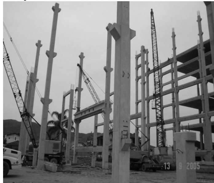
Figura 14– Rapidez de execução da estrutura pré-fabricada: pré-moldagem, planejamento e mecanização
