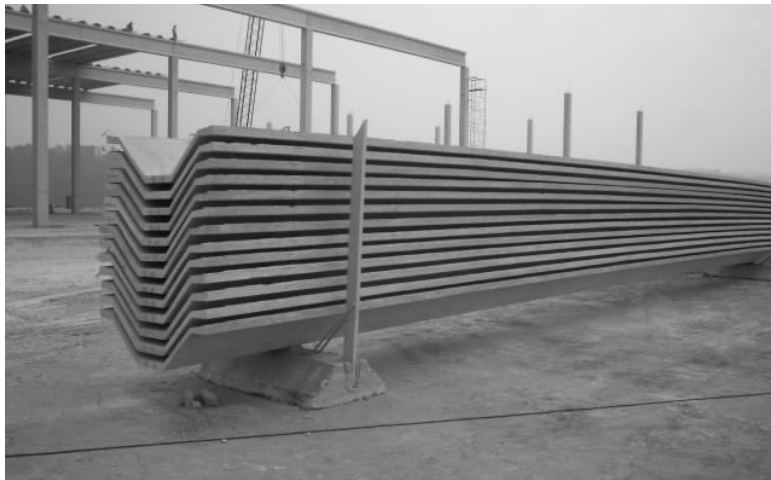
Figura 38 – Armazenamento de telha W na obra
