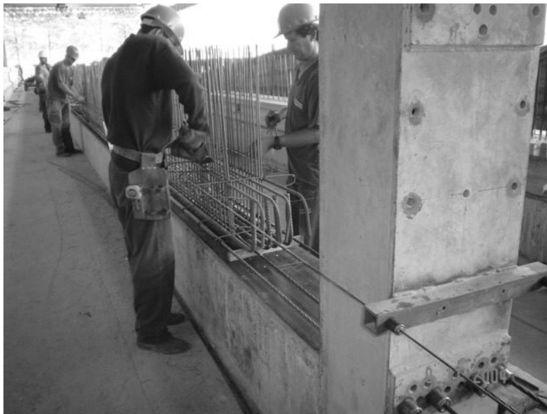
Figura 46 – Armação de concreto armado e protendido em pista de protensão de viga pré-fabricada
