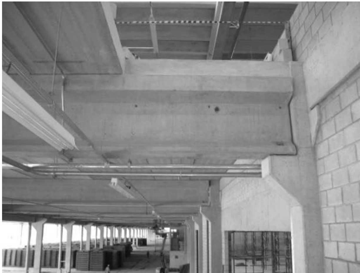
Figura 15 – Compatibilização de instalações com a estrutura pré-fabricada
