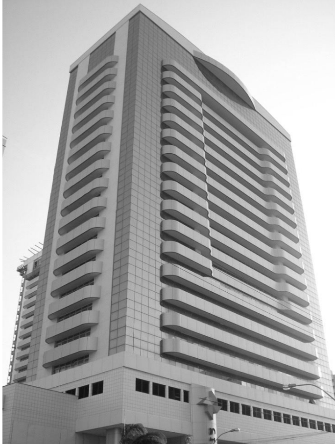
Figura 11 – Empreendimento Pátio Dom Luís em Fortaleza, CE, composta de vigas e lajes pré-fabricadas protendidas e pilares moldados no local e torres de 24 e 20 pavimentos
