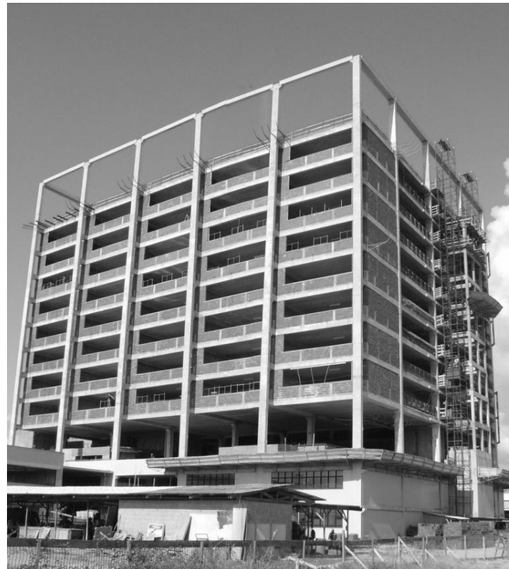
Figura 19 – Obra do edifício da Universidade Universo em Recife, PE – 12 pavimentos em estrutura pré-fabricada.
