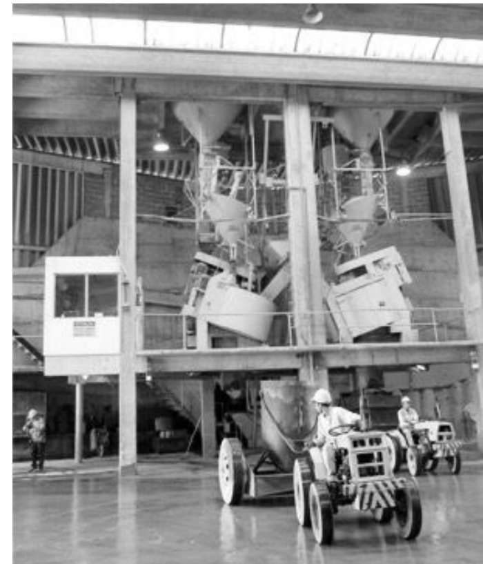
Figura 47 – Central dosadora de concreto em instalações de indústria de pré-fabricados
