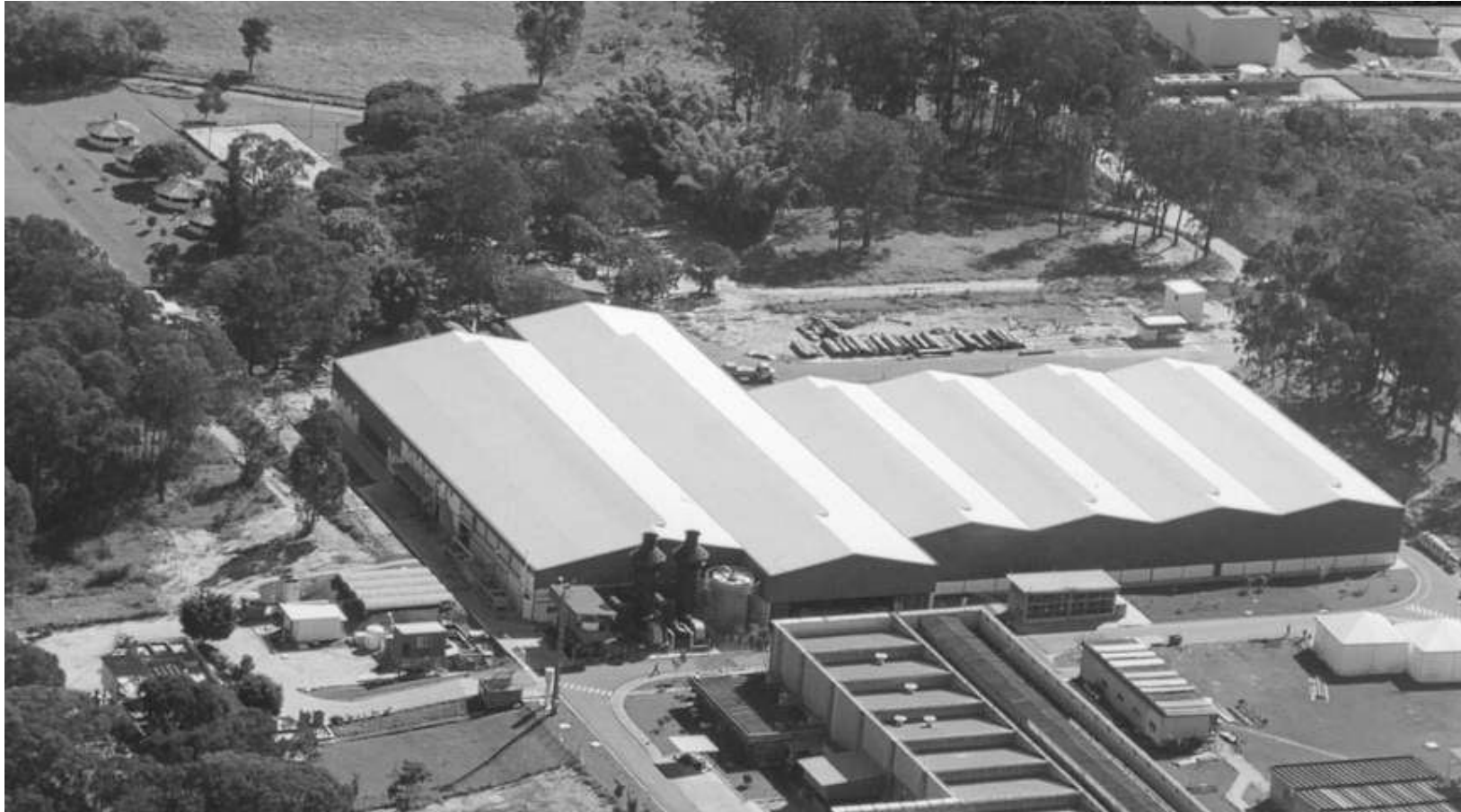
Figura 26: Galpão pré-fabricado- aplicação em obra industrial
