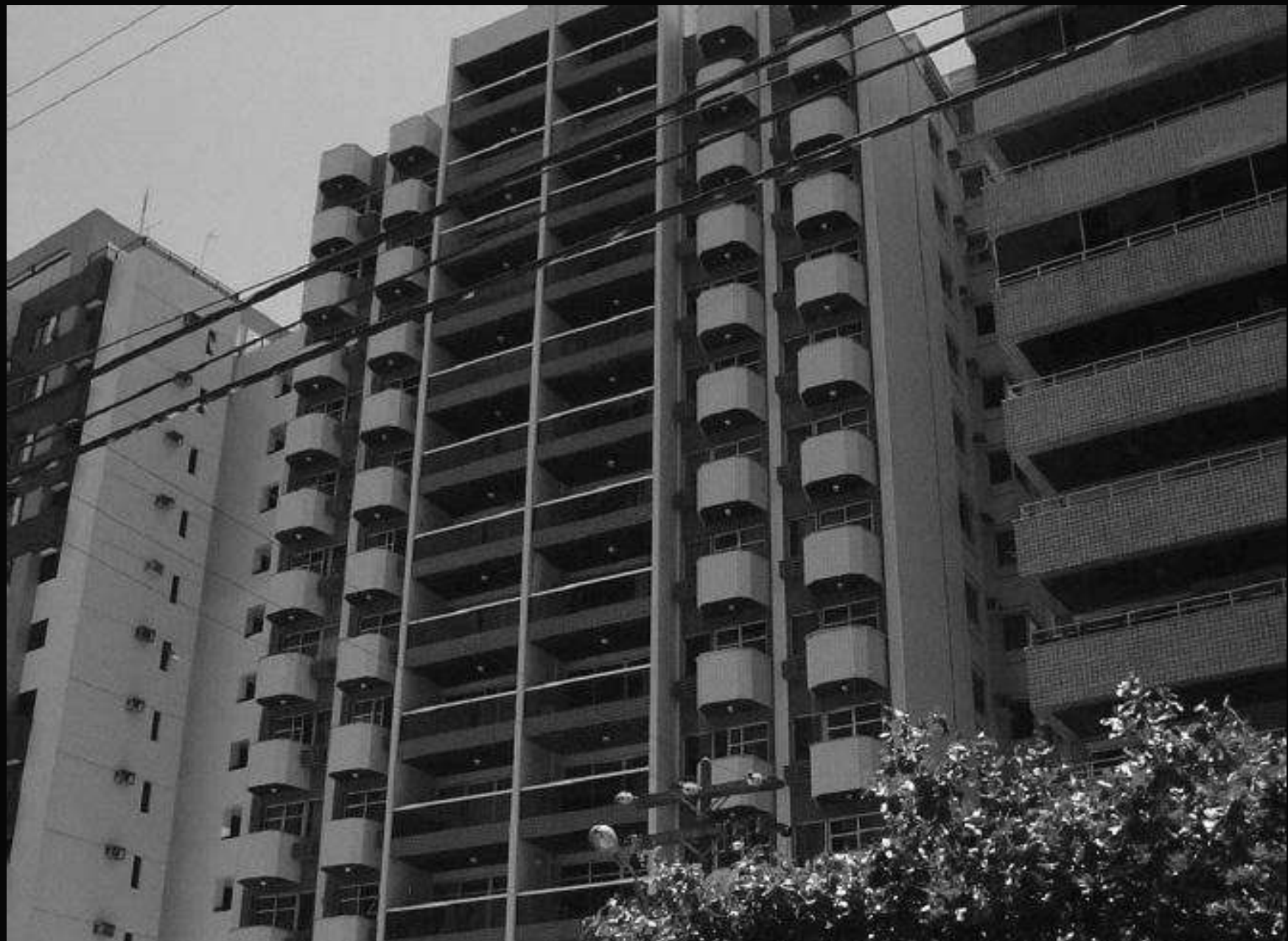
EDIFÍCIO AREIA BRANCA – Pernambuco
