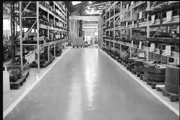
Proteção superficial de concreto
