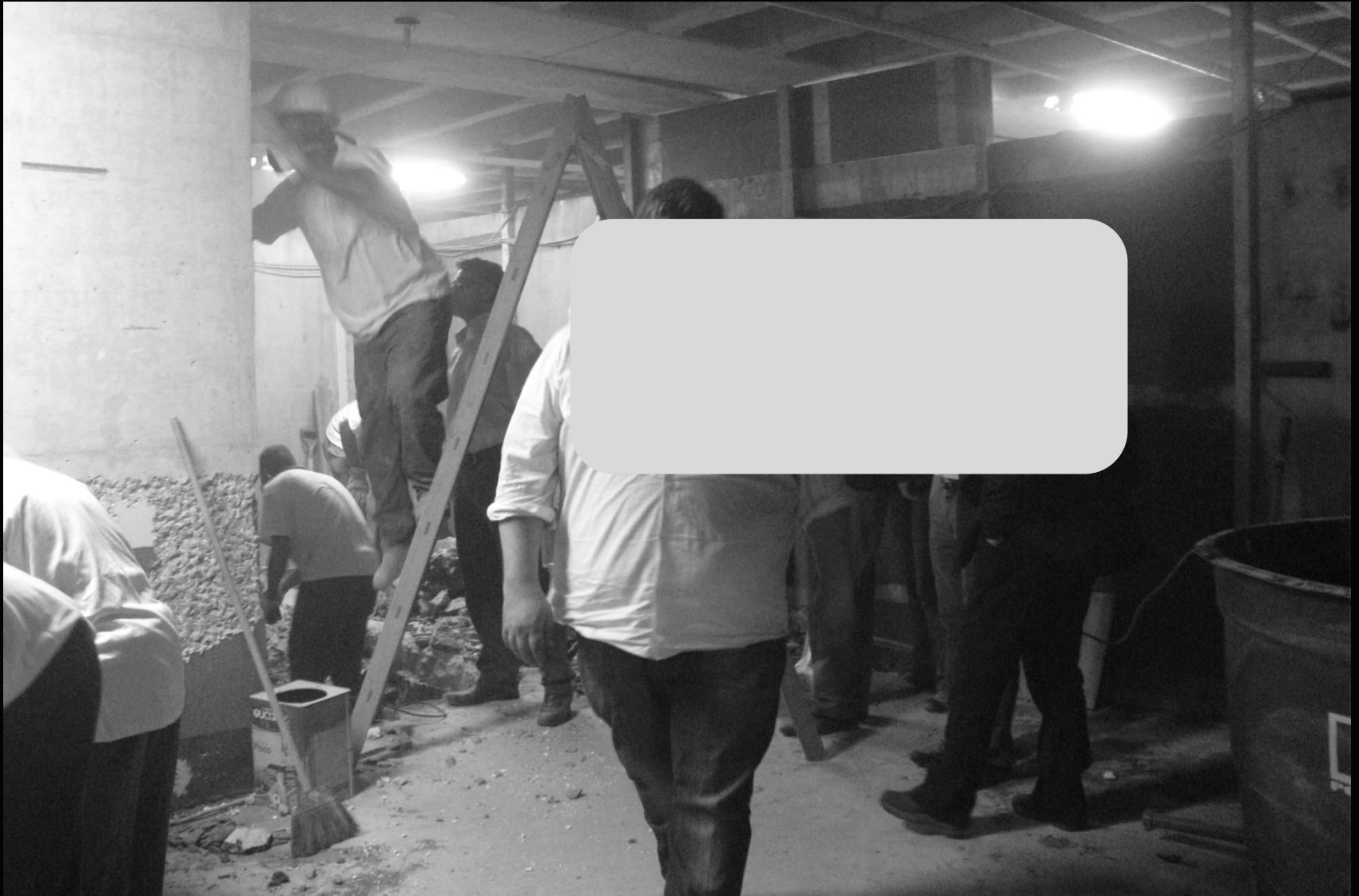
Escavação Piso fase 1
