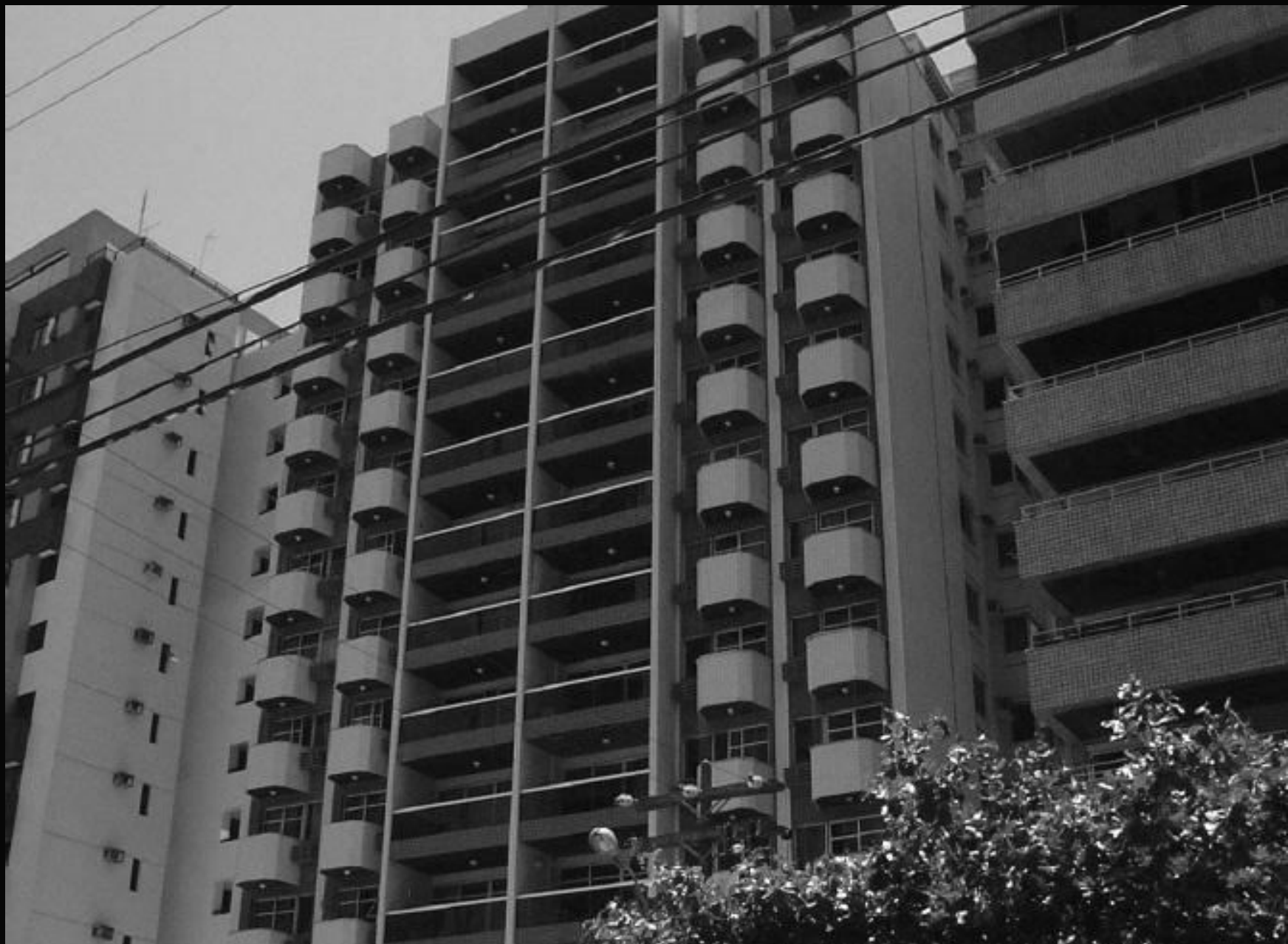
EDIFÍCIO AREIA BRANCA – Pernambuco
