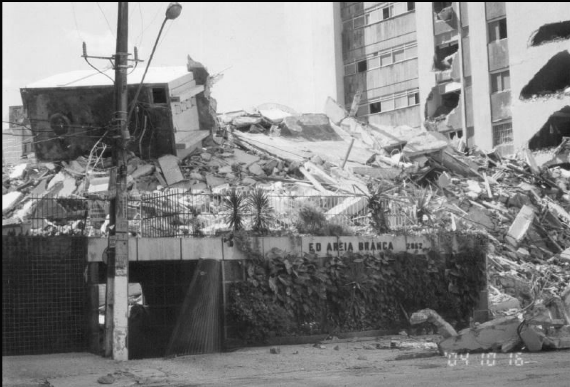
Escombros - manhã seguinte do desabamento
