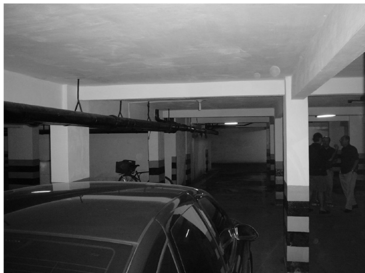
Vista geral do subsolo
