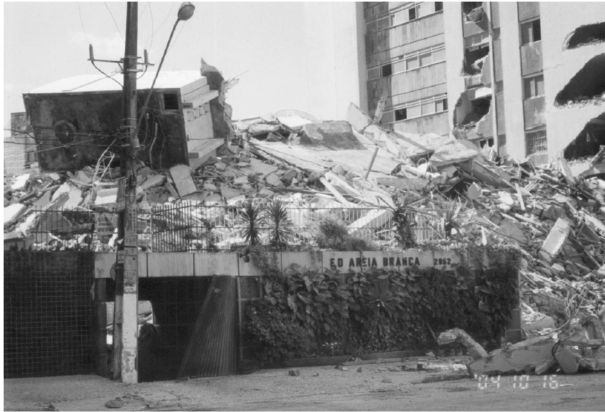
Escombros - manhã seguinte do desabamento
