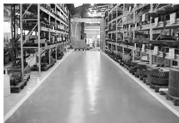
Proteção superficial de concreto
