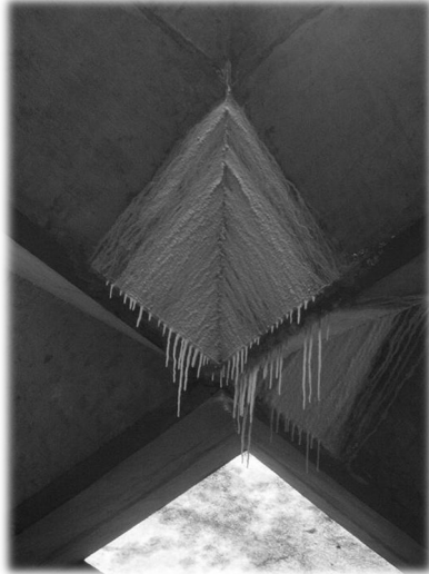
Cobertura do Prédio da FAU-USP
