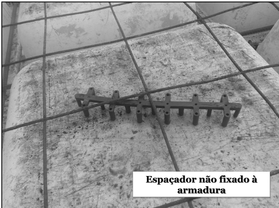
**Espaçador não fixado à armadura**
