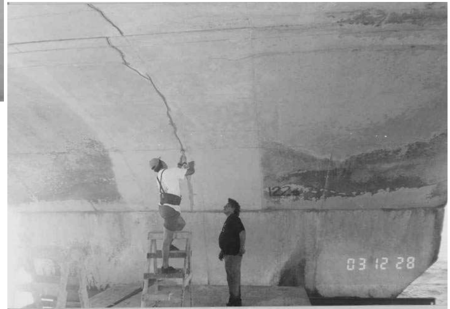
Rehabilitación de uno de los arcos agrietados
