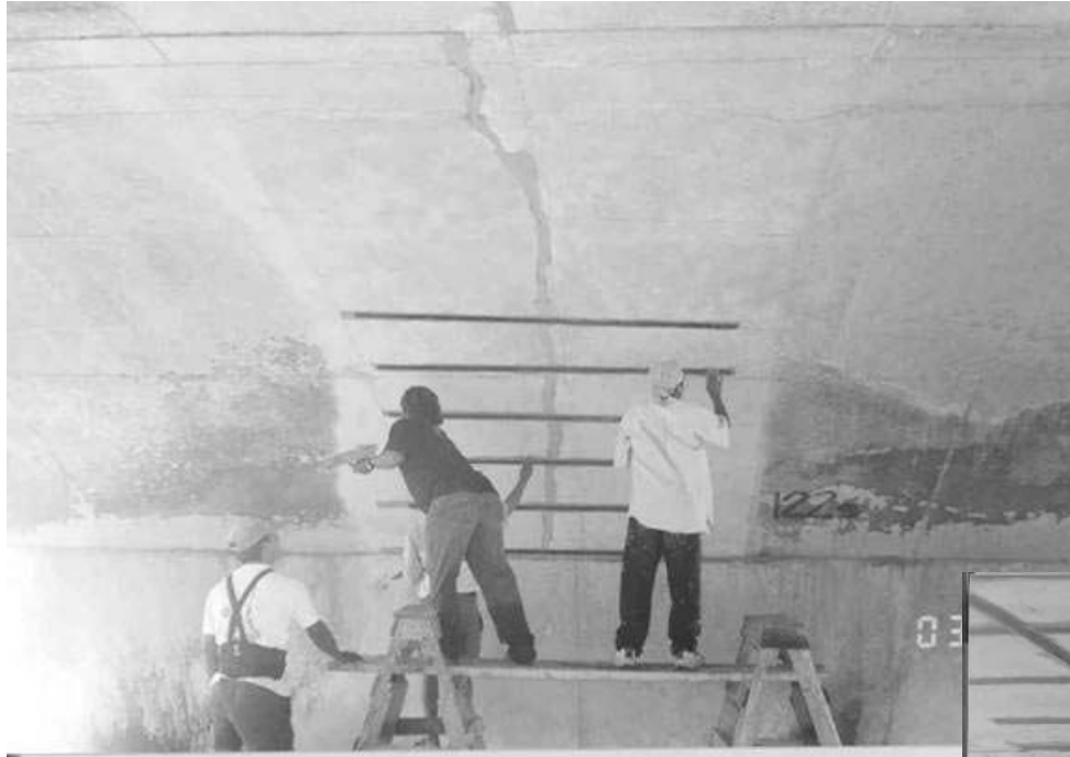
Rehabilitación de los arcos agrietados
