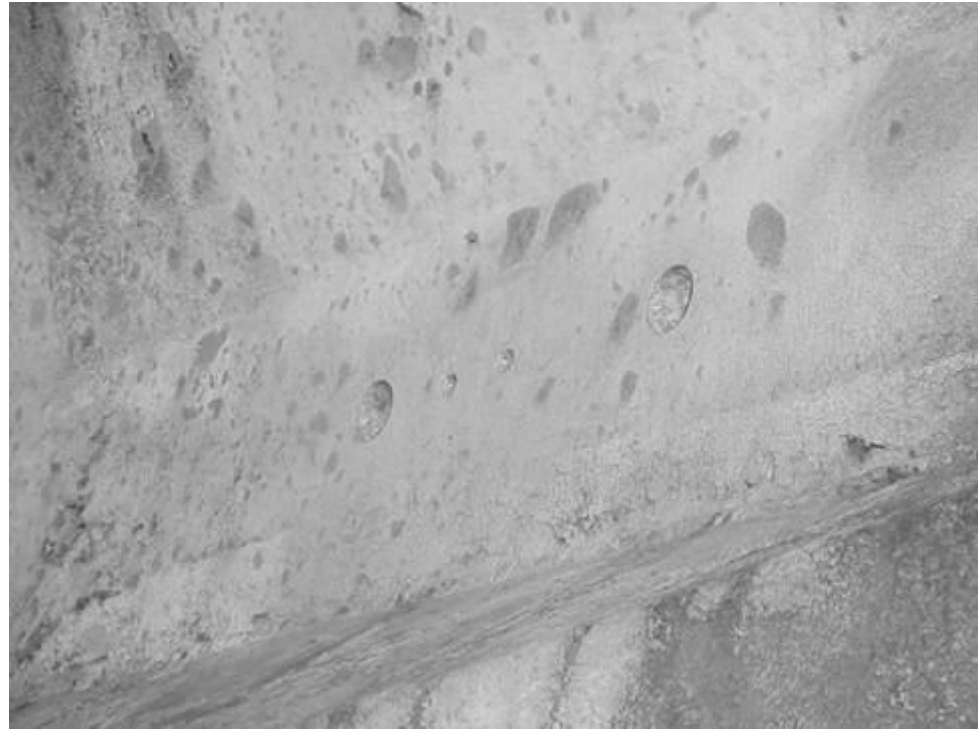
Viga, Cara Sur
