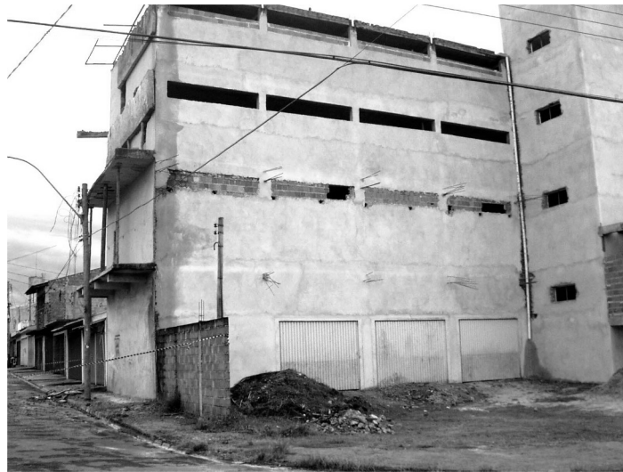
Vista da Edificação – Jardim Bicão – São Carlos
