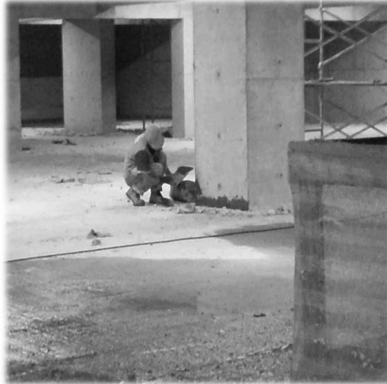
Todo reparo estrutural deve ser realizado com argamassa, graute ou concreto com resistência bem superior à do elemento. No mínimo igual.
