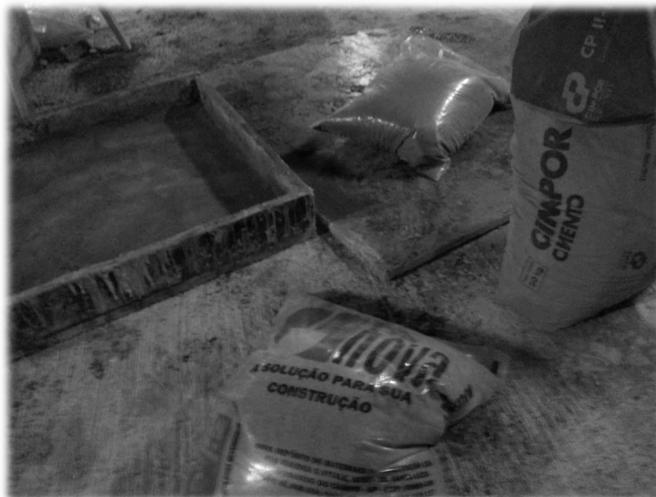
Todo reparo estrutural deve ser realizado com argamassa, graute ou concreto com resistência bem superior à do elemento. No mínimo igual.
