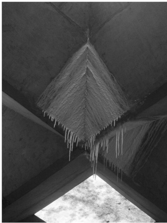
Cobertura do Prédio da FAU-USP
