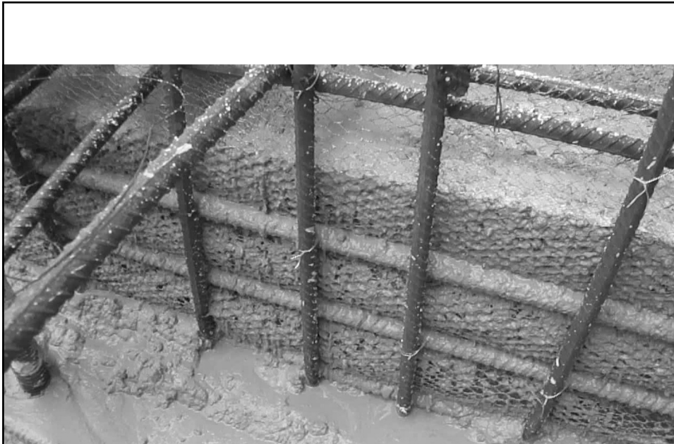
durante: concreto fluido
