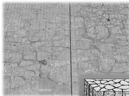
Fissuração disseminada (mapeamento)
