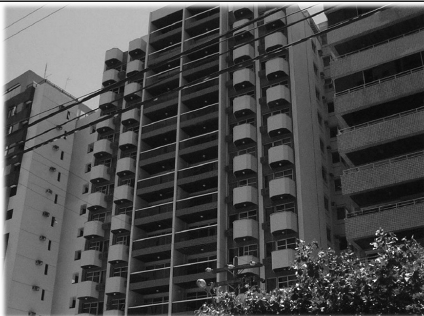
EDIFÍCIO AREIA BRANCA – Pernambuco
