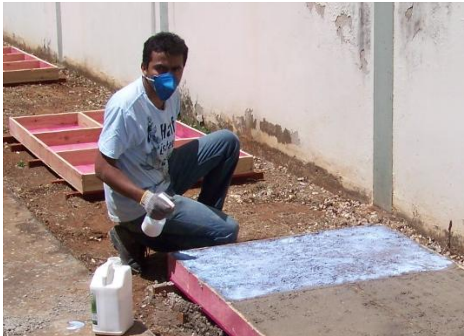
Figura 38: Aplicação da membrana química. (fonte: Autor / data: 28 de agosto de 2012).
