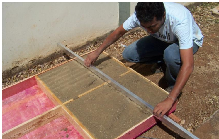
Figura 36: Regularização da superfície da placa de concreto com régua metálica. (Fonte: Autor / data 28 de agosto de 2012).
