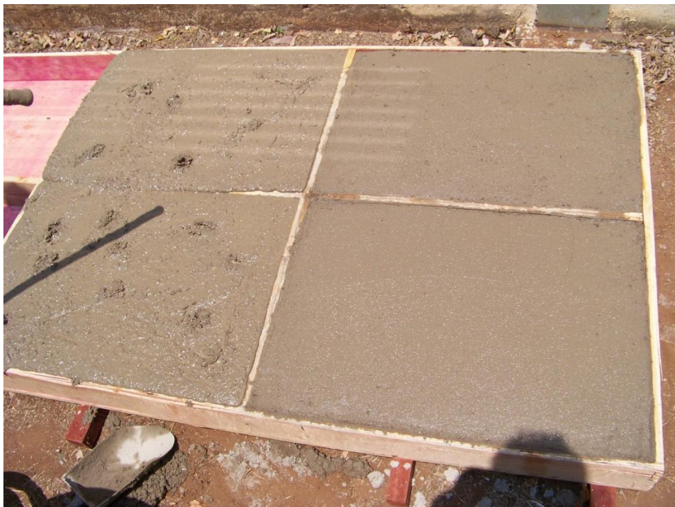
Figura 25: Execução da concretagem das placas de concreto. (fonte: Autor / data: 28 de agosto de 2012)
