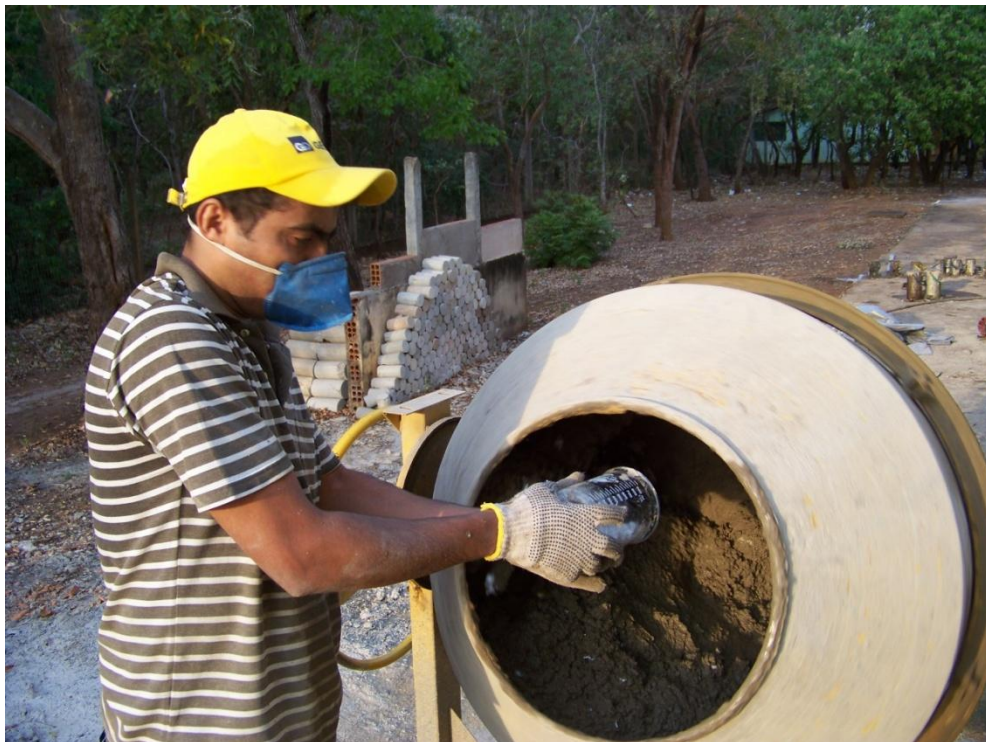
Figura 20: Adição de Fibras de polipropileno no concreto. (fonte: Autor / data: 28 de agosto de 2012)
