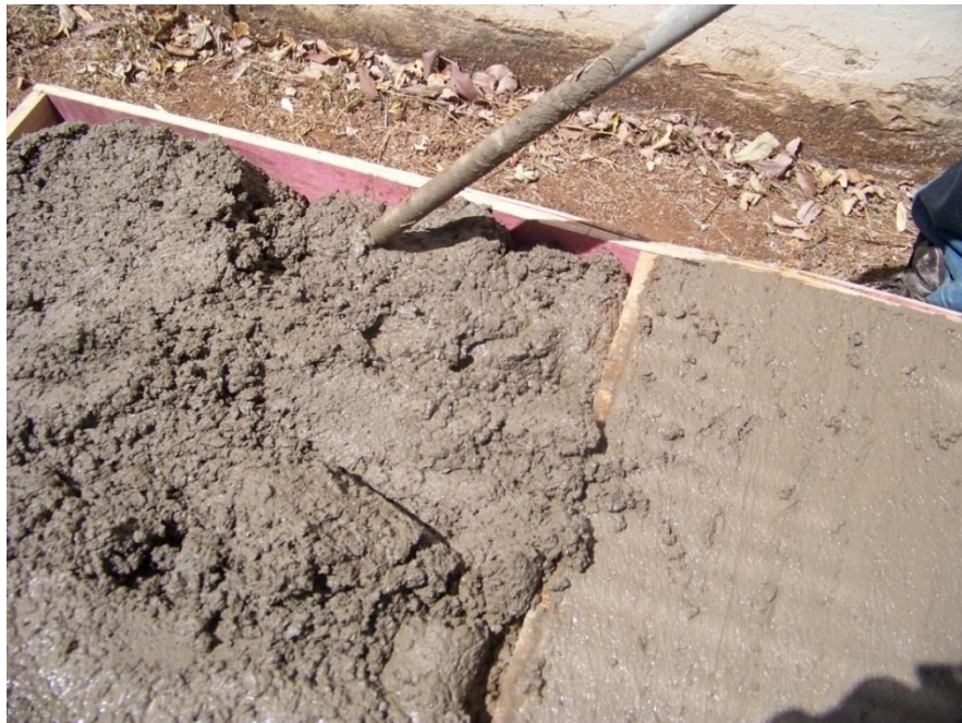
Figura 35: Adensamento mecânico. (Fonte: Autor / data 28 de agosto de 2012).
