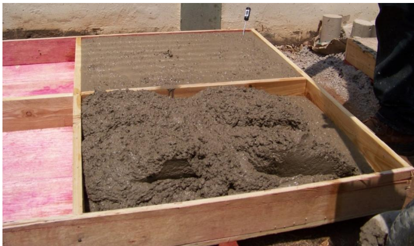
Figura 32: Lançamento do Concreto com fibras. (Fonte: Autor / data: 28 de agosto de 2012).
