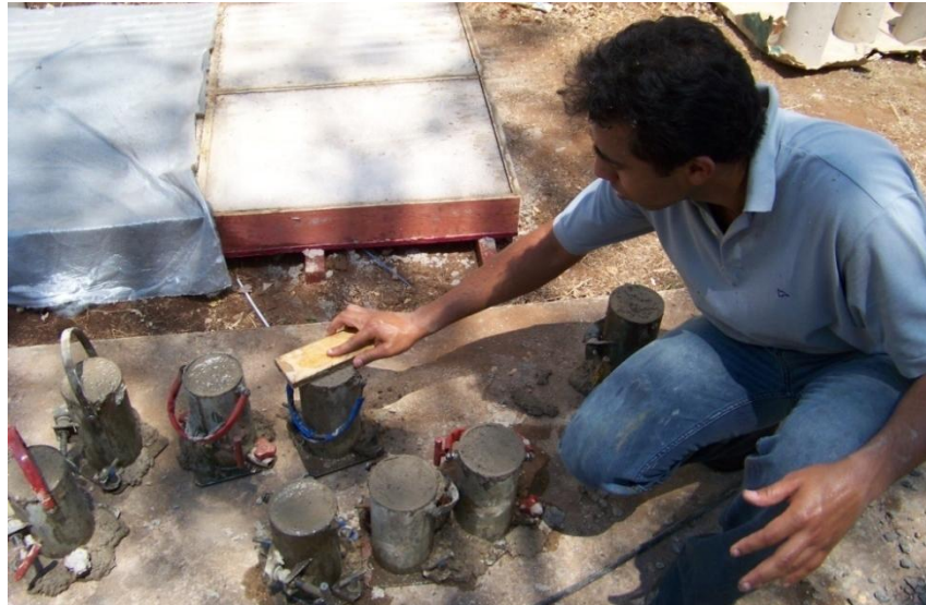
Figura 33: Moldagem dos corpos de prova. (Fonte: Autor / data 28: de agosto de 2012).
