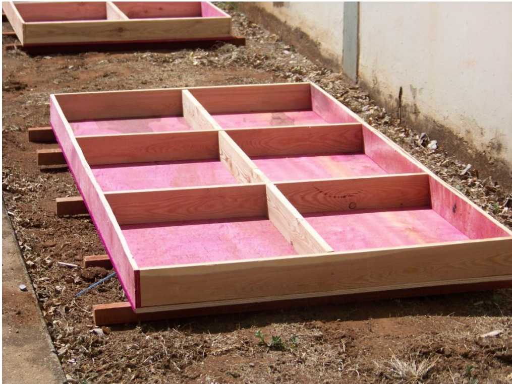
Figura 23: Fôrmas para a concretagem das placas de concreto. (fonte: Autor / data: 28 de agosto de 2012)
