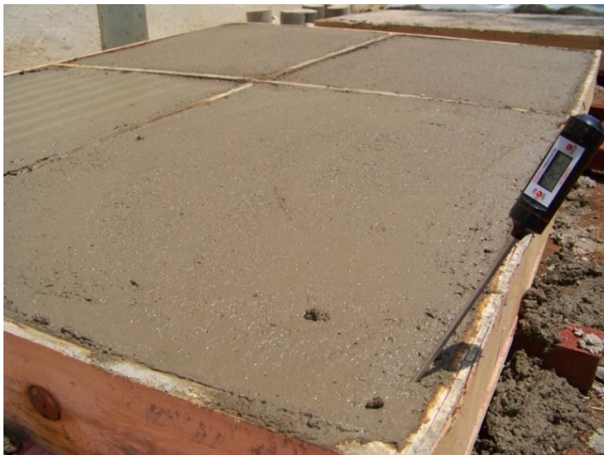
Figura 30: Monitoramento da temperatura do concreto no momento da concretagem. (Fonte: Autor / data: 28 de agosto de 2012).
