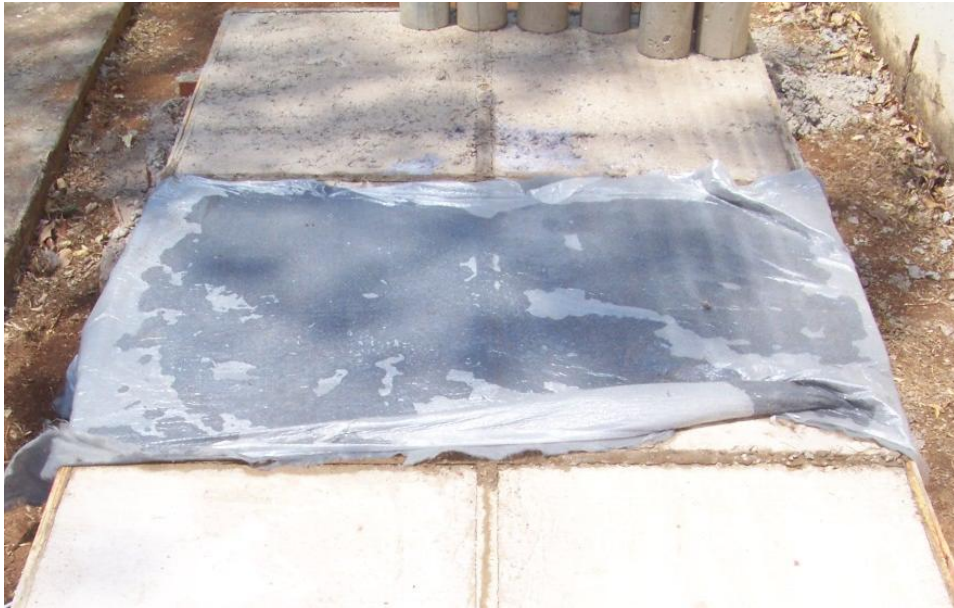
Figura 37: Aplicação da manta para cura úmida. (fonte: Autor / data: 28 de agosto de 2012)
