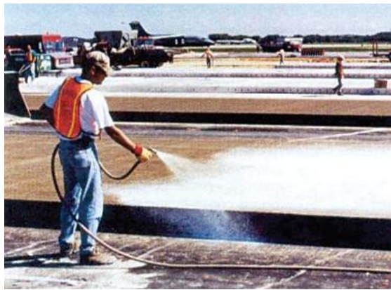
Figura 08 - Cura com película química (Fonte: ASSOCIAÇÃO BRASILEIRA DE CIMENTO PORTLAND, 2011).
