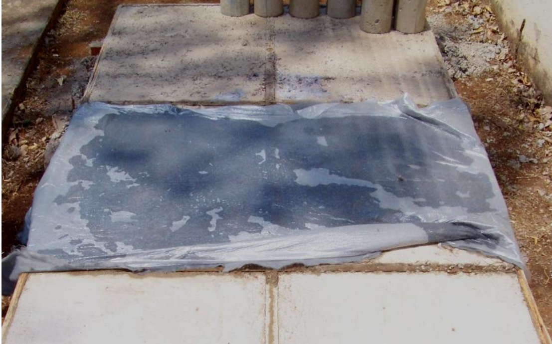
Figura 17: Aplicação da manta para cura úmida. (fonte: Autor / data: 28 de agosto de 2012).
