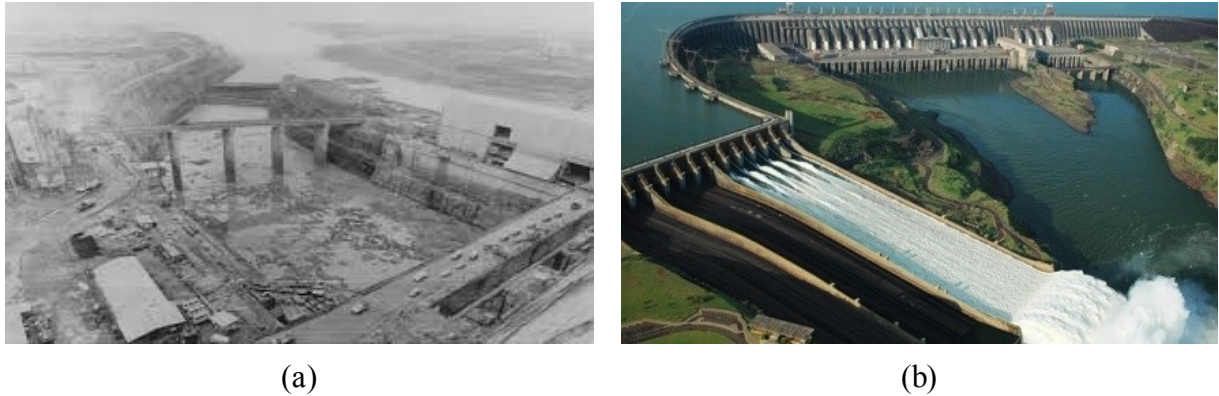
Figura 1-3. Usina hidrelétrica de Itaipu durante construção no ano de 1976 e em operação em foto de 2015. Fonte: ITAIPU BINACIONAL (2015)
