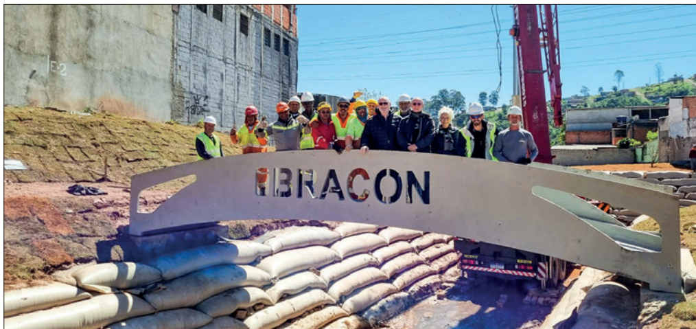
Foto 1: Passarela instalada sobre o córrego no bairro do Jardim Marilu, em São Paulo
