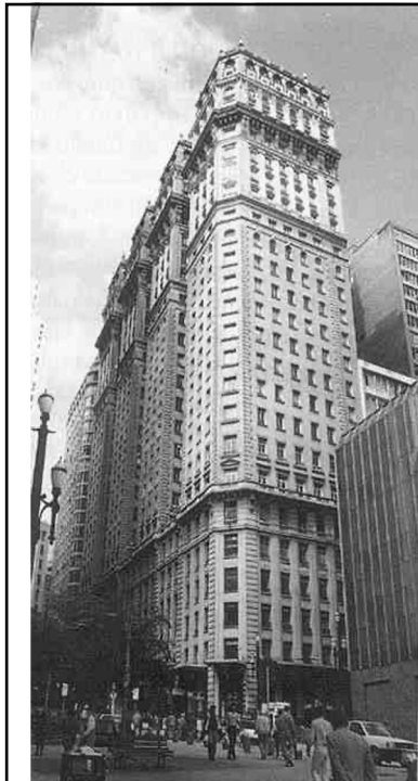
Edifício Martinelli São Paulo 1926 25 andares Altura 106 m Rua Líbero Badaró f_{ck} = 13,5 \text{ MPa}
