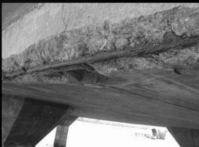
A deterioração precoce da armadura se apresenta frequentemente devido à elevada instabilidade do aço frente a ambientes agressivos
