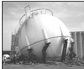
O acidente ocorreu devido a uma severa corrosão nas colunas de suporte devido à infiltração de água internamente à proteção contra fogo "Fire Proofing".
