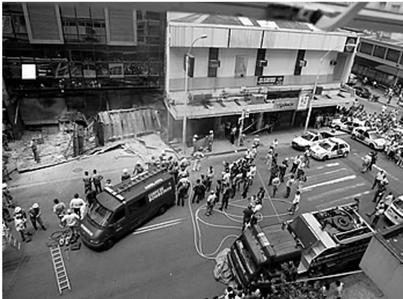
QUEDA DA MARQUISE DO HOTEL CANADÁ - RJ
