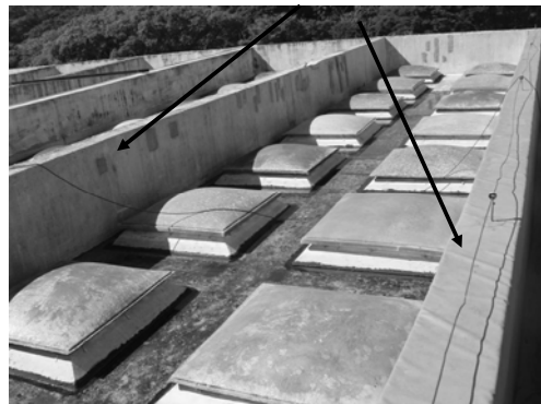
Recuperação e proteção inicial das vigas estruturais
