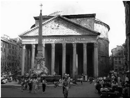
Cúpula do Panteão Século II dC → Diâmetro de 44m
