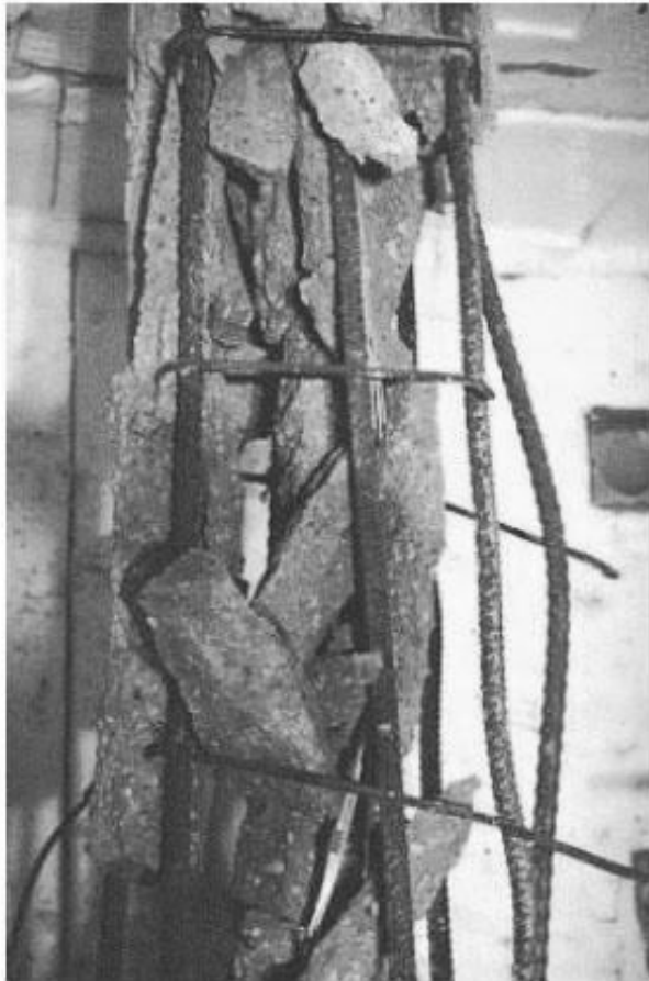
Configuração Convencional de Estribos
