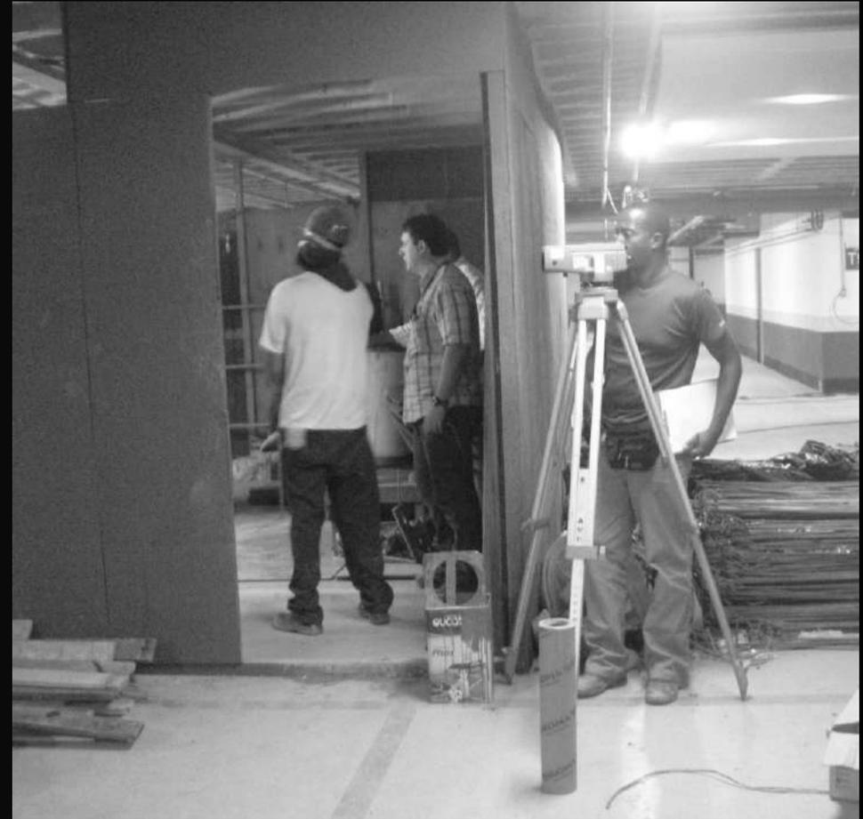
**Controle contínuo de deslocamento vertical (recalque) dos pilares P4, P1A e P7**
