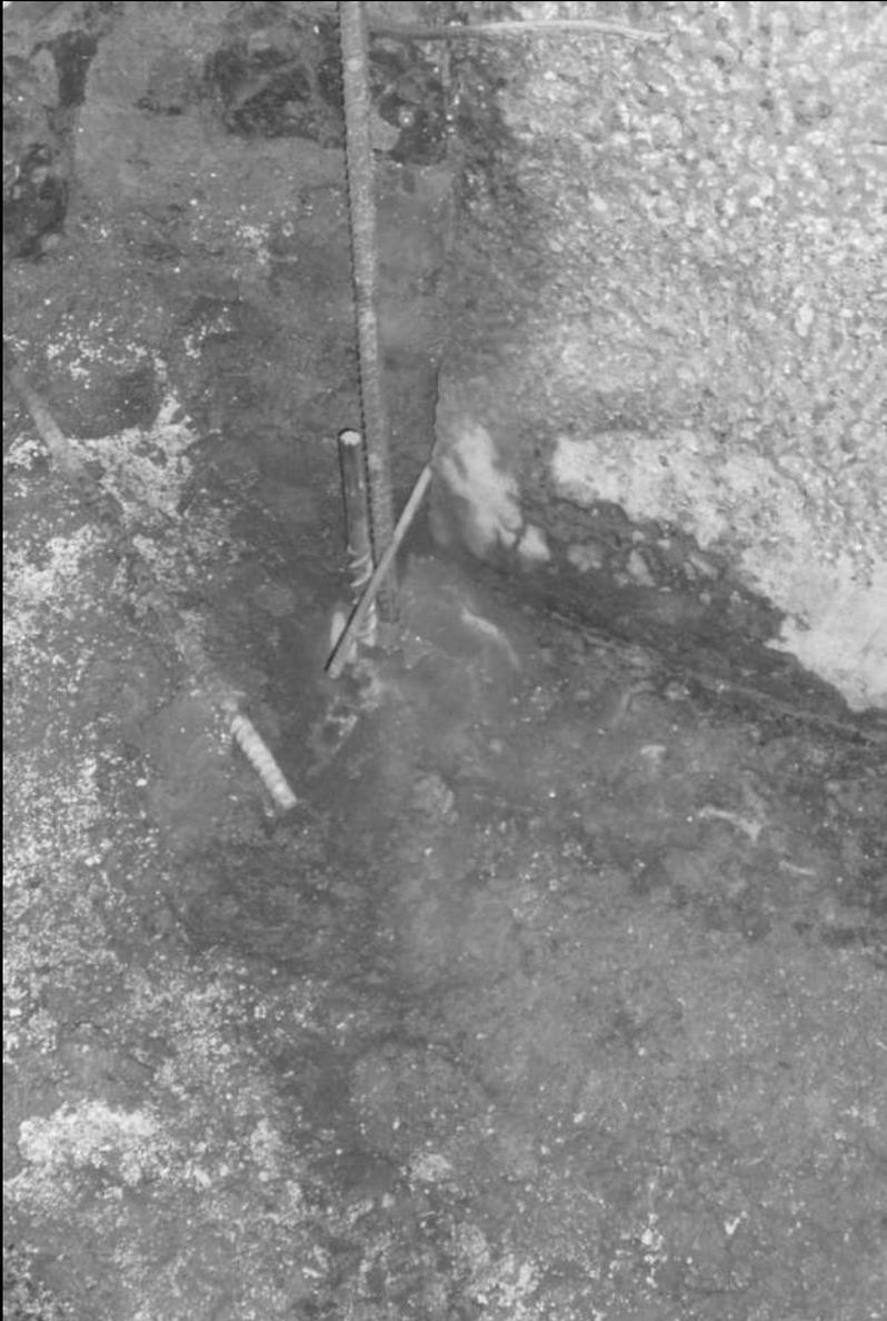
Broca perdida porque errou na bitola do furo, preencheu com epóxi e decidiu-se re-furar no mesmo furo que já tinha epóxi.
