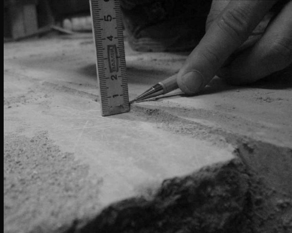
*Após concretagem piso desceu 4mm*
