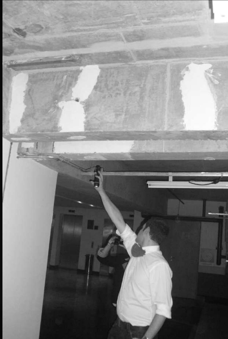
**Desnívelamento e fissuras em vigas**
