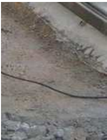
Rugosidade da superfície recém-escarificada, devendo ser lixada
