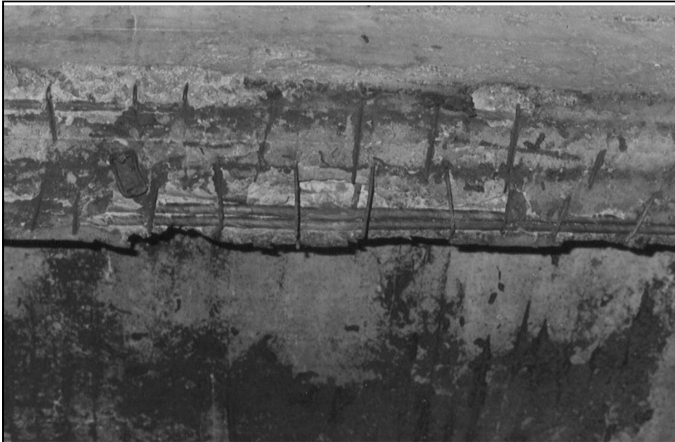
aspecto tipico de las vigas
