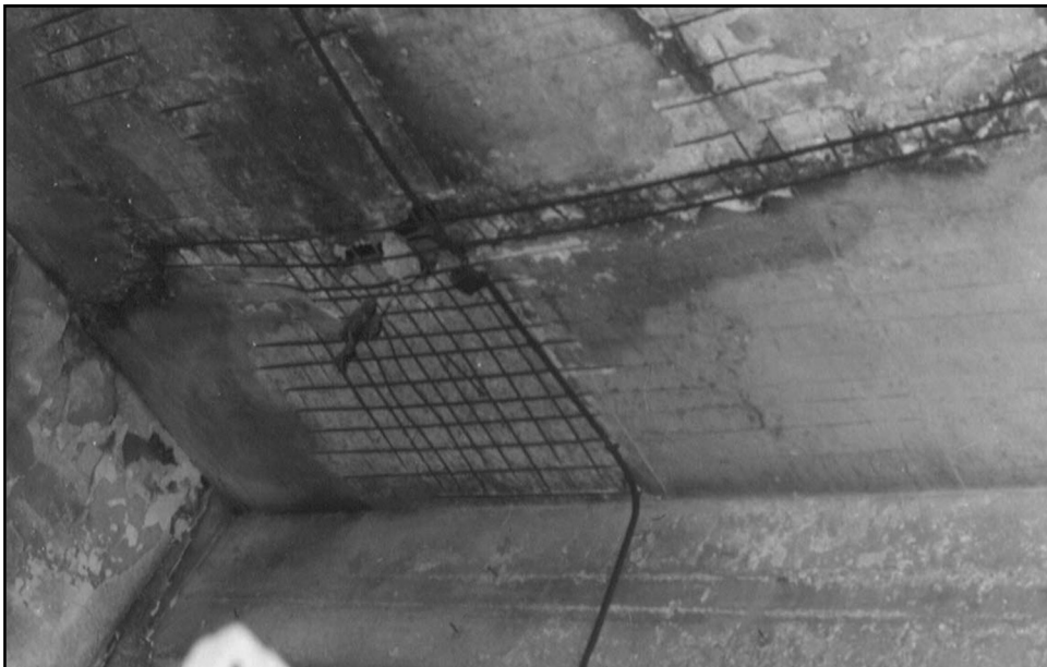
aspecto tipico das losas
