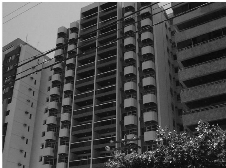
EDIFÍCIO AREIA BRANCA – Pernambuco
