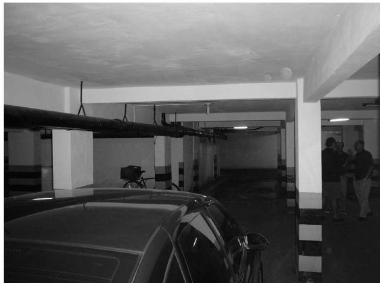
Vista geral do subsolo
