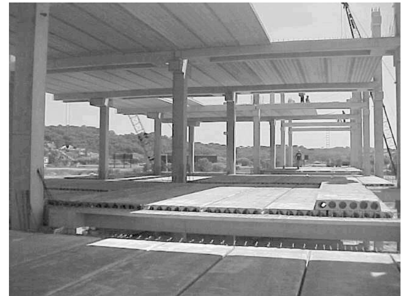
Figura 25: Galpão pesado - montagem
