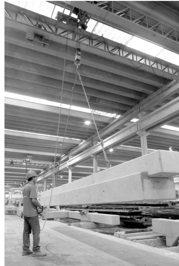
Figura 37 – Movimentação de viga pré-fabricada durante a produção
