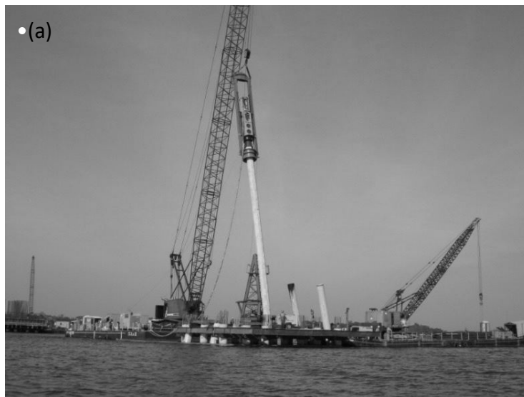
Figura 34 – Estacas pré-fabricadas: (a) cravação e aplicação em meio altamente agressivos e (b) armazenamento
