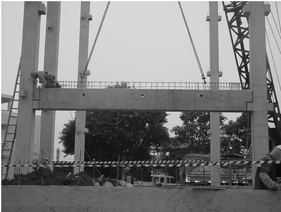
Figura 43: Montagem de viga x tolerâncias de montagem
