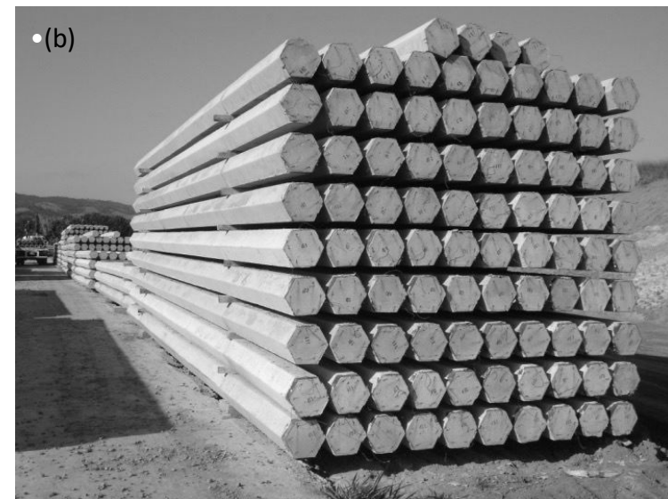
Figura 34 – Estacas pré-fabricadas: (a) cravação e aplicação em meio altamente agressivos e (b) armazenamento
