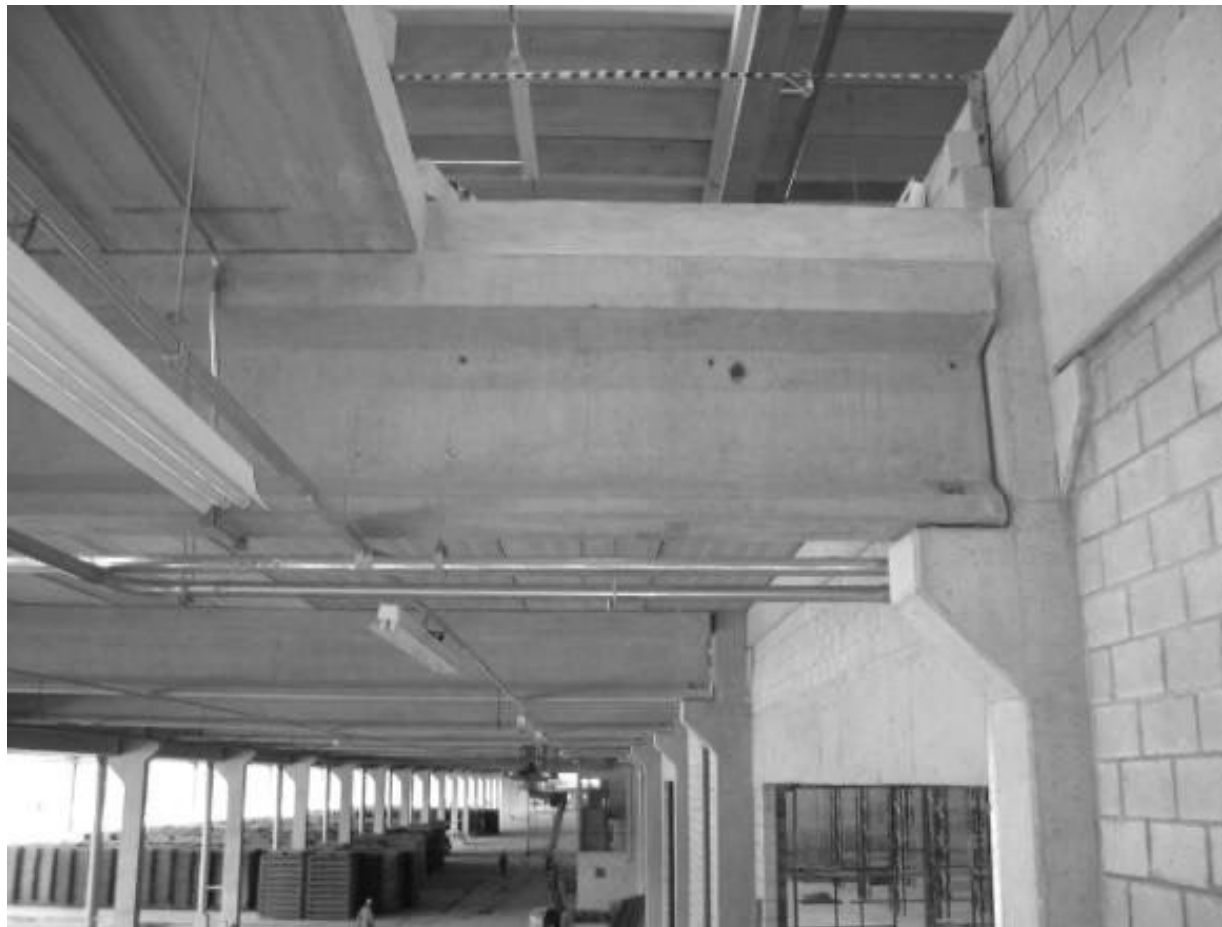
Figura 15 – Compatibilização de instalações com a estrutura pré-fabricada
