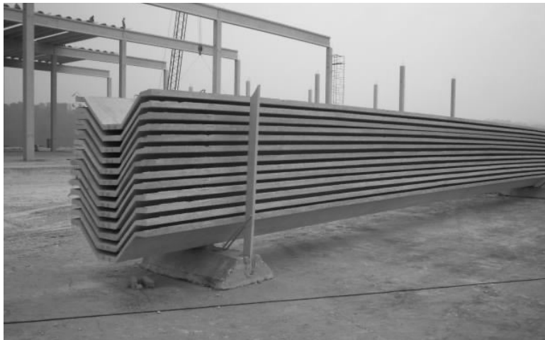
Figura 38 – Armazenamento de telha W na obra
