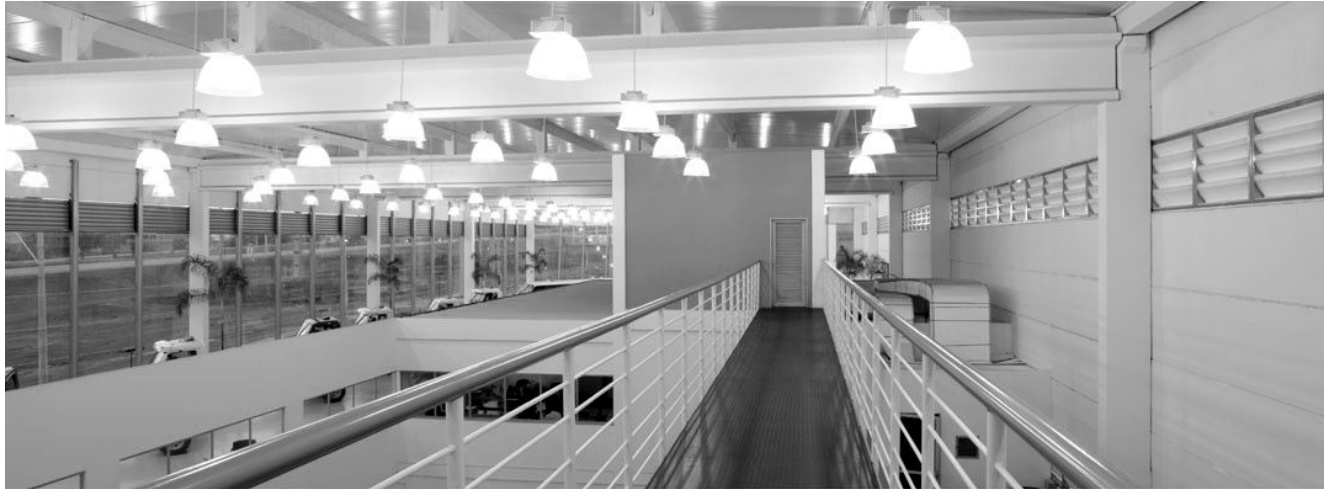
Figura 24: Galpão pesado – acabamento interno
