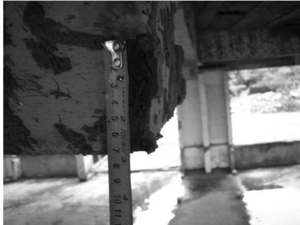
Medição de flechas em vigas
