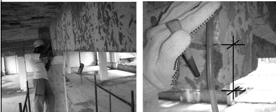
Medição de flechas em vigas
