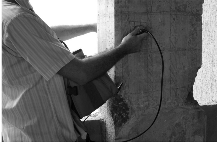
Medida de propagação de ondas ultrassônicas e do potencial de corrosão
