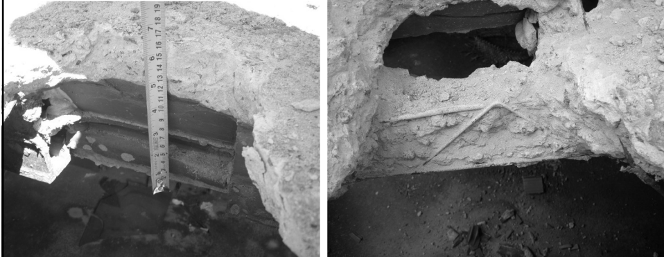
Caracterização da laje do Forro
