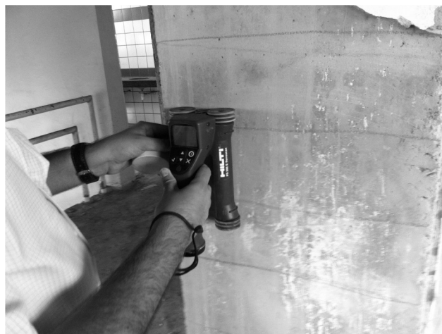
Pacométria de pilares para locação de armaduras
