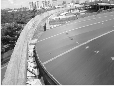
Viga sem continuidade e com armadura cortada no apoio da cobertura acrílica
