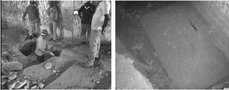
Escavação de fundação – Vistoria da Sapata e verificação de cota de apoio
