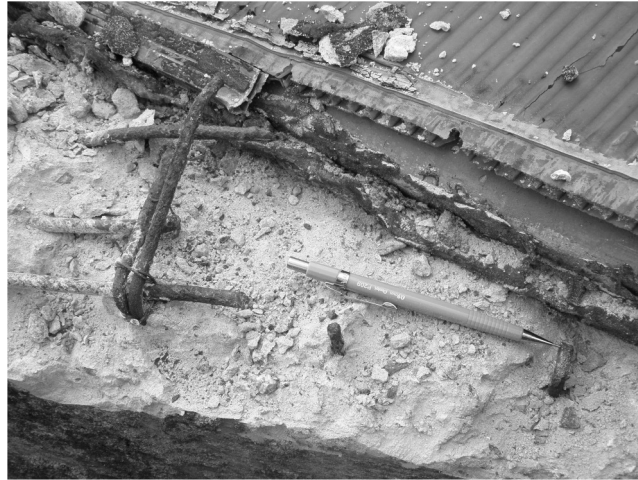
Armaduras cortadas em todo apoio da cobertura acrílica
