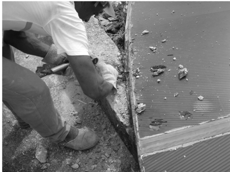
Inspeção das armaduras da viga V38 do Forro
