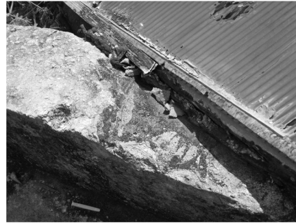
Viga sem continuidade e com armadura cortada no apoio da cobertura acrílica
