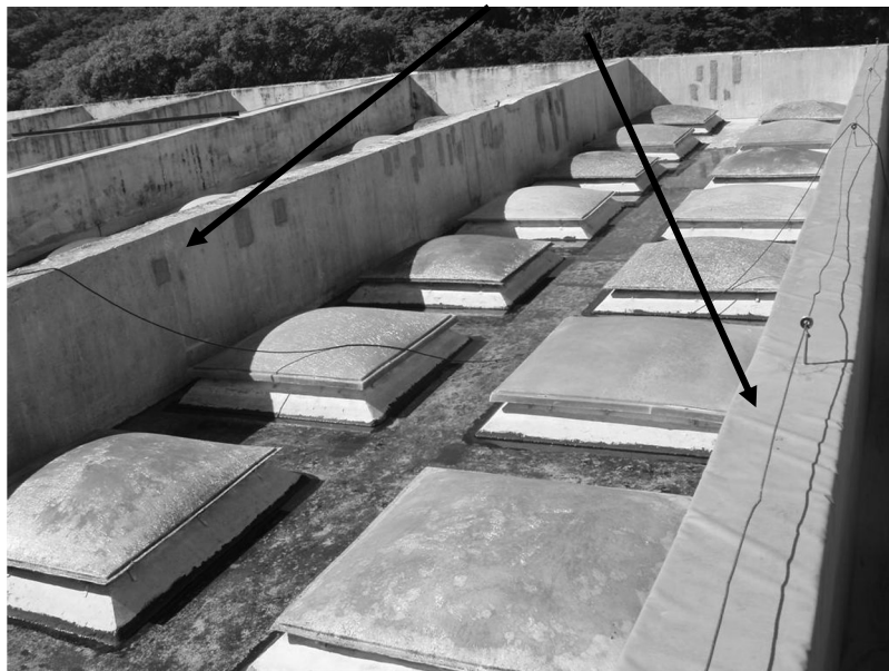
Recuperação e proteção inicial das vigas estruturais
