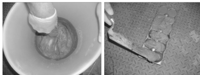
Fig. 4 – Detalhe da argamassa sendo preparada e vertida na forma de caixa de ovos.
