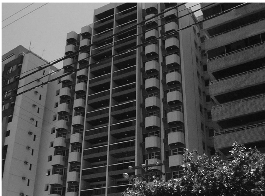
EDIFÍCIO AREIA BRANCA – Pernambuco
