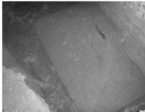
**Escavação de fundação - Vistoria da Sapata e verificação de cota de apoio**
