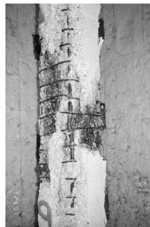
Configuração Modificada de Estribos
