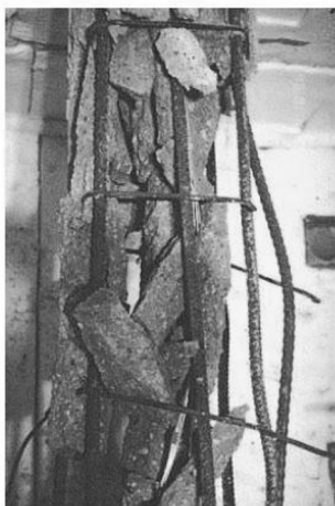
Configuração Convencional de Estribos
